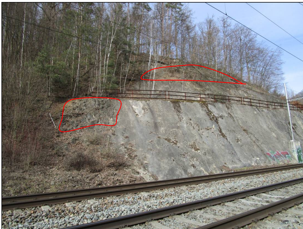
Obr. č. 7 – svah zakrytý torkretem, červenou čarou jsou znázorněna místa navrženého rozšíření torkretu v rámci sanace
