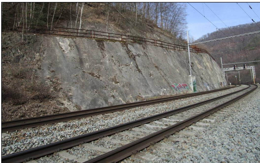
Obr. č. 5 – svah zakrytý torkretem celkový pohled směr Blansko
