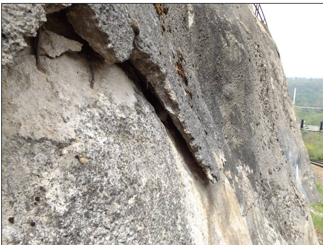
Obr. č. 6 – pohled na opady betonu, v místech opadů je odhalena ocelová výztuž
